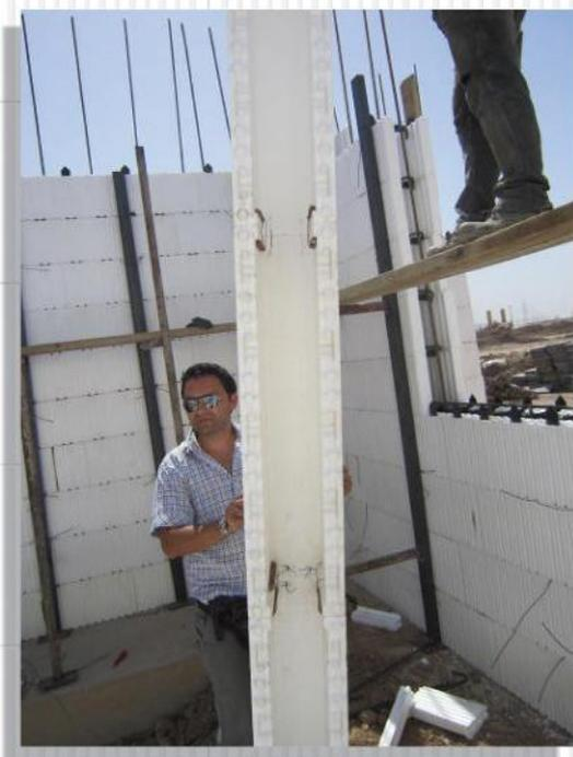
۳-۳-۱۵ در صورت لزوم جهت اتصال ۲ و یا چند قالب نعل درگاه به یکدیگر ضمن اتصال مناسب به یکدیگر، زیر قالب نعل درگاه بویژه در محل اتصال شمع بندی شود. توصیه می شود با قرار دادن یک تخته در زیر کل مجموعه و تعیبه پایه به میزان کافی کل مجموعه کاملاً فیکس (محکم و ثابت) شود.
