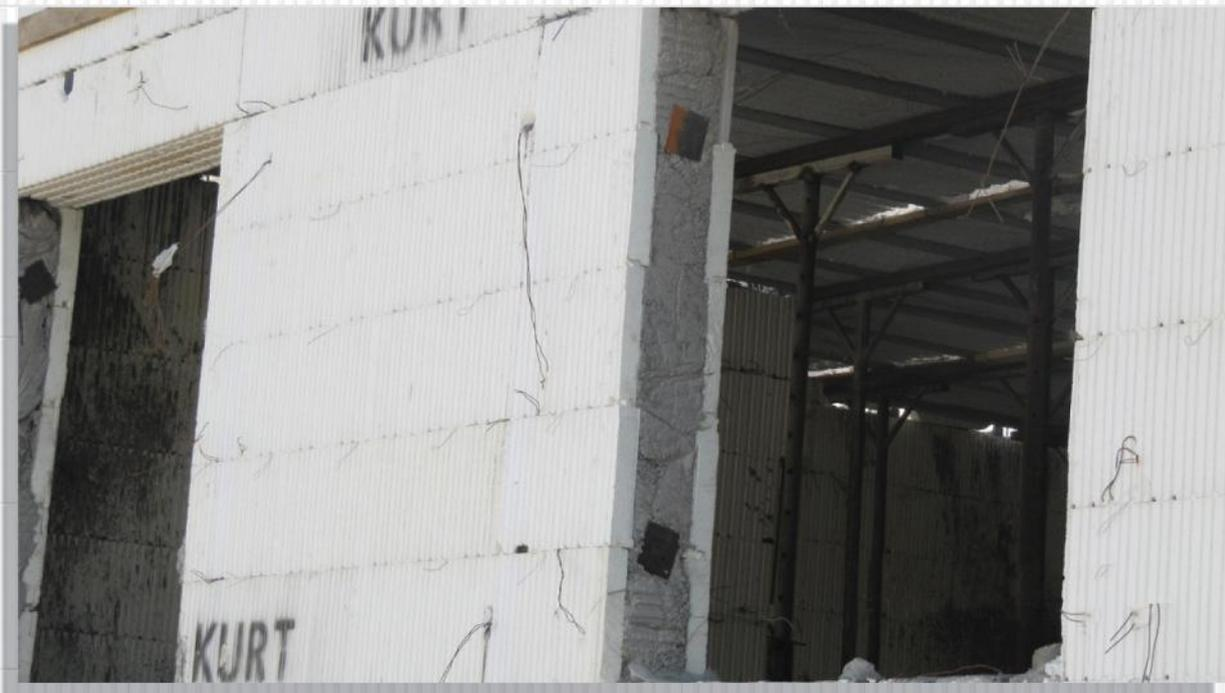
■ ۱۸-۳-۳ برای اتصال چهارچوب درب و پنجره نیز می توان از صفحه فلزی و شاخک یا بولت استفاده نمود. با توجه به ارتفاع معمول درب و پنجره ها، تعبیه ۳ شاخک برای درب و ۲ شاخک برای پنجره ها پیشنهاد می گردد.
