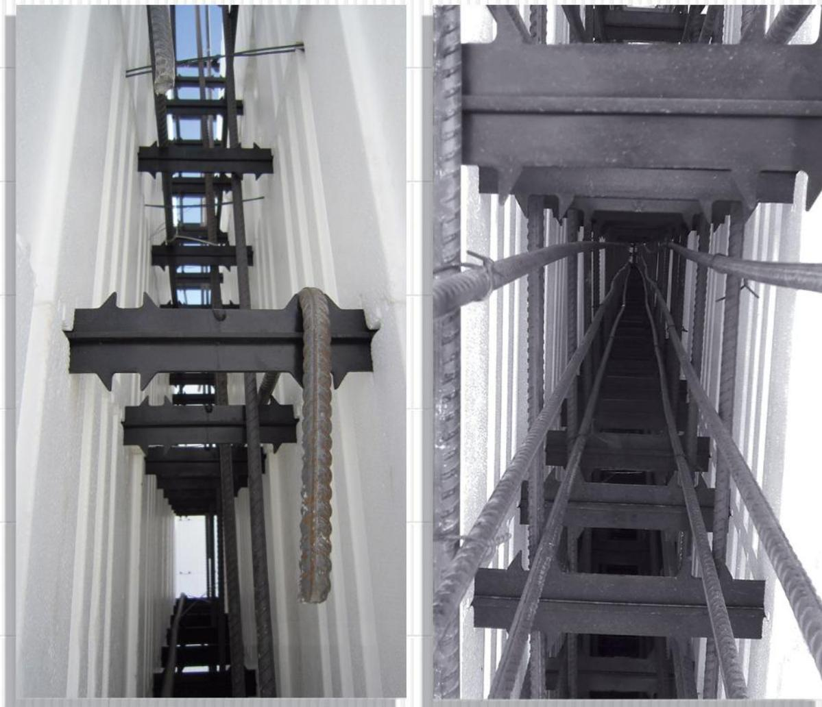
در فواصل ۱ متری ارتفاعی به میلگردهای عرضی بویژه بالاترین میلگردهای عرضی بسته شوند. ضمناً در صورت تک بودن میلگرد عرضی مطابق نقشه های سازه ای باید یکی در میان در ارتفاع دیوار طرفین محل های پیش بینی شده بر روی رابط پلاستیکی قرار داده شوند.
