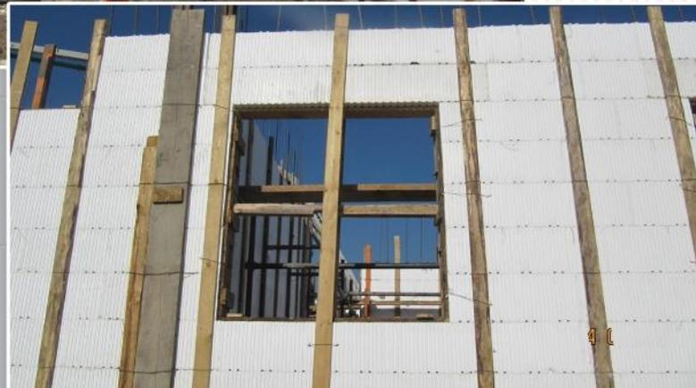
در این حالت حتماً پشت بند در پشت محل اتصال دیوار عمودی قرار می‌گیرد و دو کنج داخلی محل اتصال با قرار دادن تخته و بستن کل مجموعه پشت بند و تخته‌ها به یکدیگر با سیم آرماتوربندی دولا کاملاً" فیکس (محکم و ثابت) می‌شوند تا از تغییر شکل و دوران در محل اتصال جلوگیری می‌شود. در برخی دیوارهای داخلی با وجود اتصال + شکل، هر چهار کنج داخلی می‌بایست با تخته و سیم آرماتوربندی دولا به یکدیگر بسته شوند و در نزدیکترین فاصله ممکن به محل اتصال در هر دیوار پشت بند فلزی قرار گیرد.
